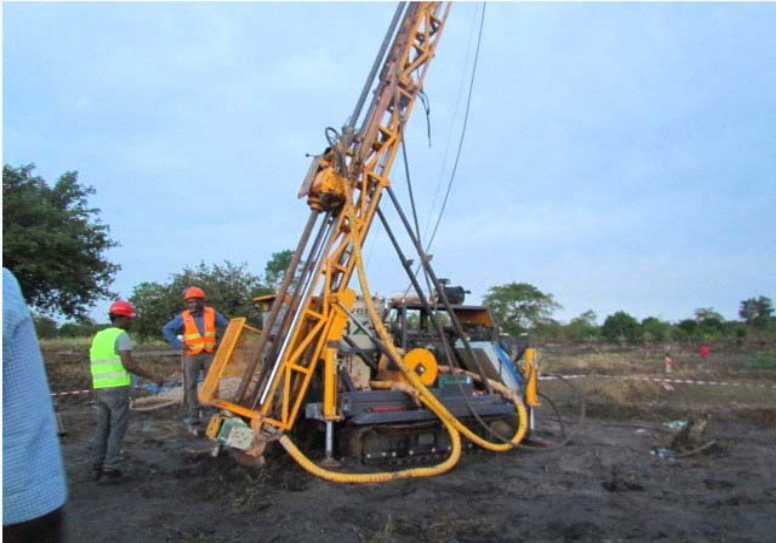
Picha Na.6: Uchorongaji kwa njia ya Diamond Drilling (DD) ukiendelea katika eneo la Itumbi - Chunya
